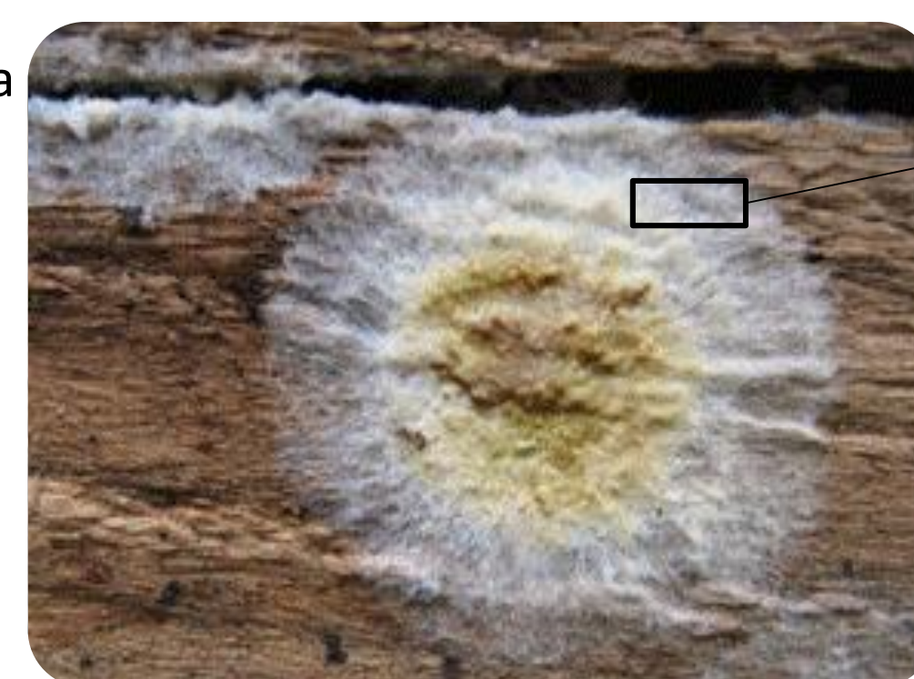
Fig. 2 Wood damage caused by Coniophora puteana . Sachverständigenbüro für Holzschutz, 2016.
